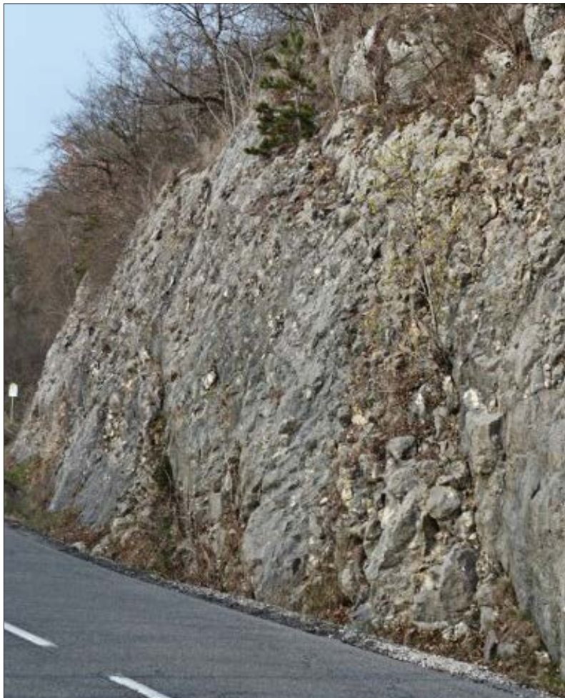
Fig. 6. Réseau de failles longitudinales et subverticales visible notamment en bordure de la route de Monnetier, affectant les calcaires urgoniens.
