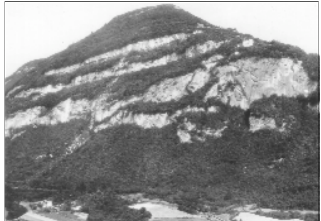
Le Petit Salève avec la trace de l'éboulement du 31 décembre 1954, peu avant 1962 (Collection G. Lepère).
