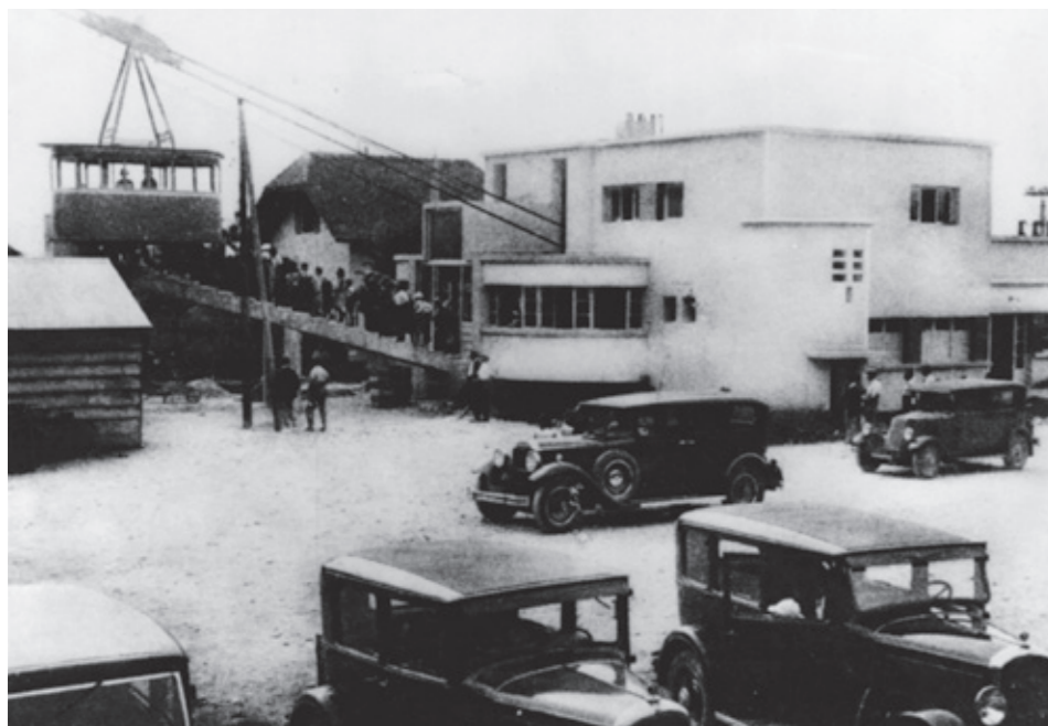
Gare de départ, état d'origine.
