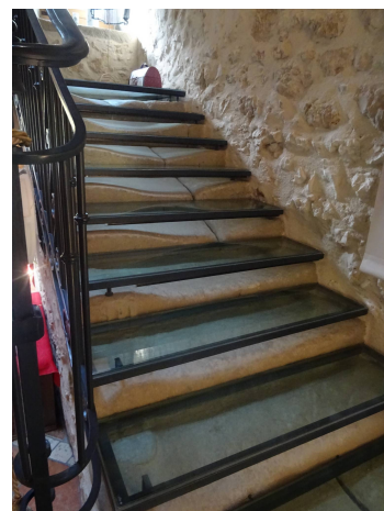
Un escalier bien usé mais rénové
