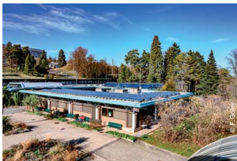
Centrale photovoltaïque sur la toiture de la Maison des Jardiniers aux CJB
