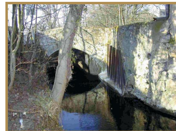
Le pont de Grange-Collomb.
