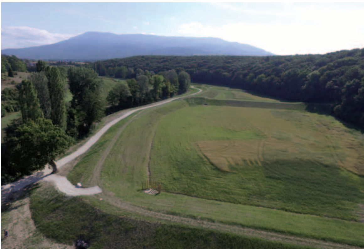
Figure 63: Bassins d'amortissement des crues sur le Foron (mis en service 2016) – photo: SIFOR
