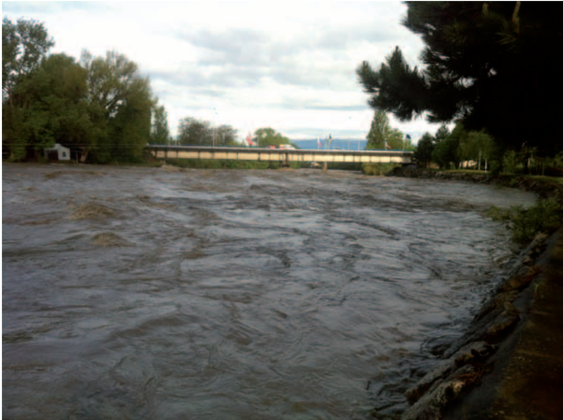
Figure 62: crue centennale de l'Arve à Annemasse (mai 2015) – photo: Grand Genève
