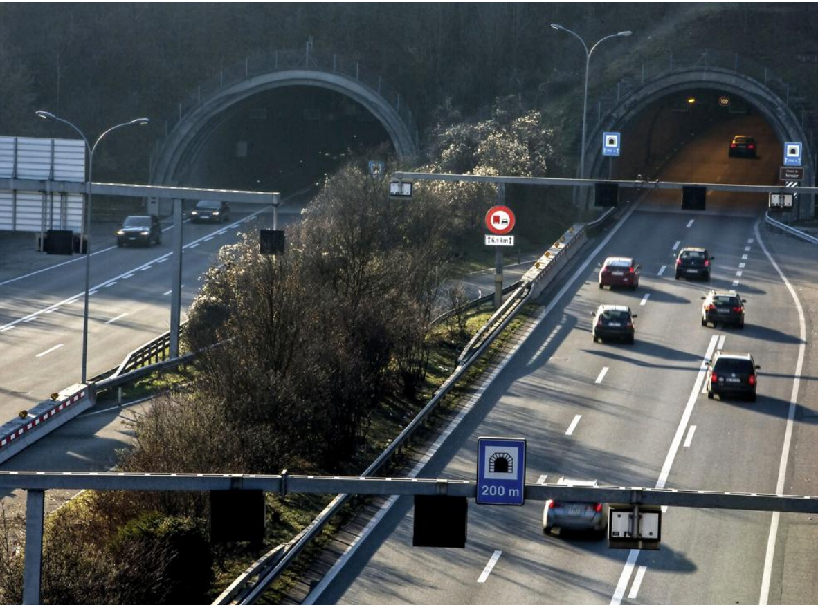
Actuellement, plus de 80 000 véhicules empruntent chaque jour le tunnel de Vernier. PIERRE ALBOUY
