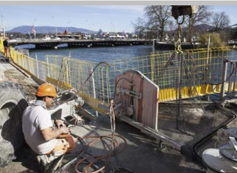
Sciage d'une partie de l'encorbellement à la hauteur du pont des Bergues.
