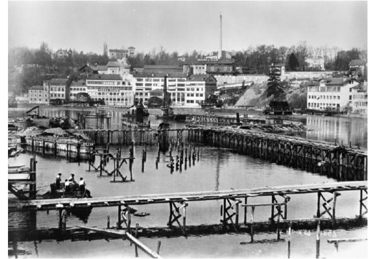
Figure 32: construction du Bâtiment des Forces Motrices à Genève en 1885. En arrière plan, on distingue les roues hydrauliques qui alimentent divers établissements industriels de Saint-Jean: minoterie, ateliers horlogers et mécaniques. Les machines hydrauliques destinées à alimenter le ville en eau potable sont déplacées du Pont de la Machine dans les nouveaux bâtiments. Le premier Jet d'eau à pour fonction de décharger la pression de l'eau non utilisée (BGE, Centre d'iconographie genevoise).
