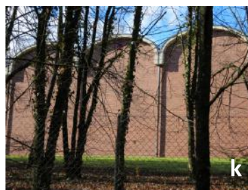
Figure k: station de traitement des eaux prélevées dans l'Arve avant la réinfiltration (vue depuis 502 110/ 115 260).
