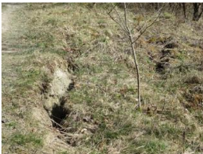
Figure m: fissures dans le terrain le long du chemin. Il s'agit du début d'un nouvel arrache-ment.
