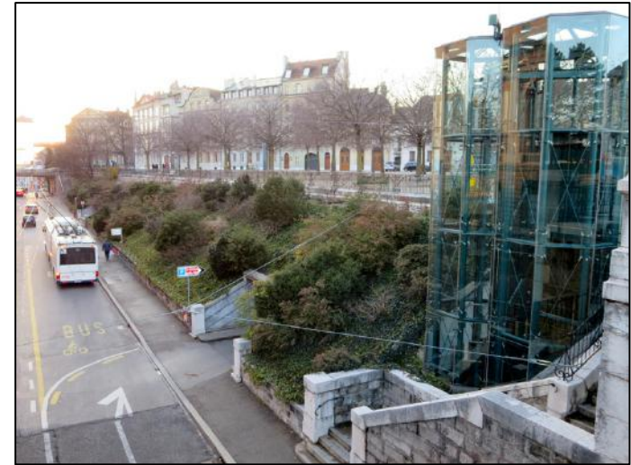
Figure b: promenade et parking Saint-Antoine vus depuis le pont traversant le Boulevard Jaques-Dalcroze. La construction du parking a remis au jour d'anciennes fortifications de la ville et le Delta.
