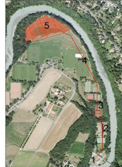
Figure e: installations de réalimentation de la Nappe du Genevois à Vessy: (1) prise d'eau (pompage dans l'Arve); (2) canalisation vers la station (longueur 340 m); (3) station de traitement; (4) canalisation vers l'aire de réalimentation (longueur 700 m); (5) aire de réalimentation (drains souterrains, longueur 5000 m (De los Cobos 2012).
