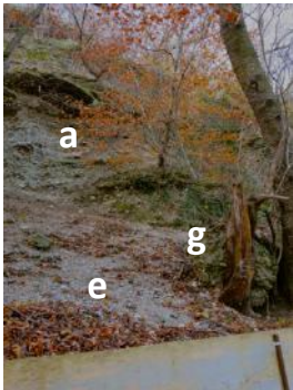
Figure a: éboulis (e) et petit glissement de terrain (g) entre la falaise de l'Alluvion ancienne (a) et le sentier.
