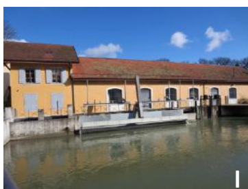
Figure l: centrale hydroélectrique de Vessy; site de prélèvement de l'eau de l'Arve (vue depuis 502 005/ 114 920).
