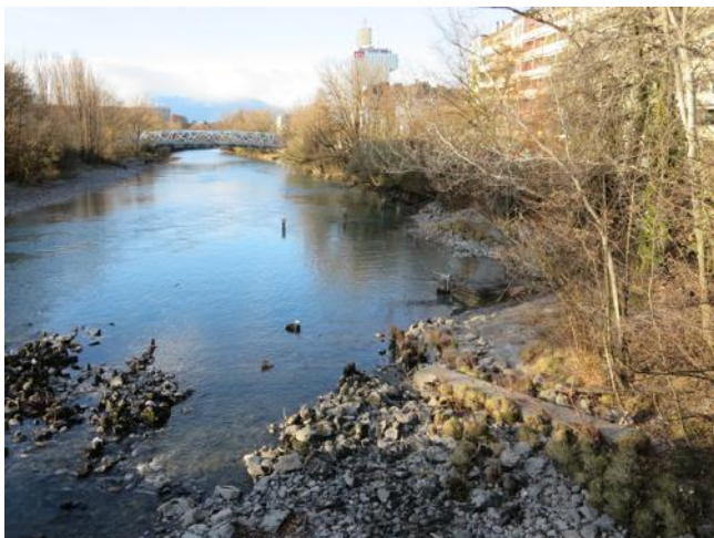
Figure a: chenal rocailleux de l'Arve en amont du Pont Hans Wilsdorf. Sur la rive droite on reconnaît l'étroite terrasse sab-leuse des crues annuelles. Prise de la photo en automne 2013 par un débit de 38 m 3 /sec.
