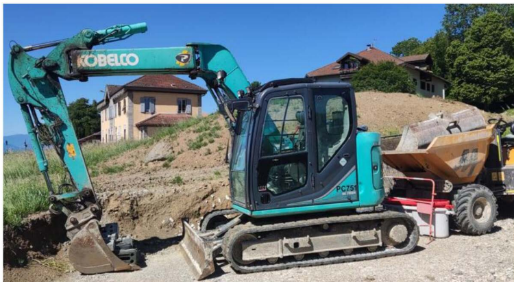
Les travaux à l'école sont à l'arrêt au groupe scolaire et périscolaire d'Andilly/Saint-Blaise. Photo Le DL/SC.
